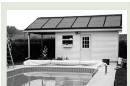
*Installation typique idéale: un pavillon secondaire au toit incliné, orienté Sud ou Sud-Ouest. La proximité de la piscine réduit les pertes de charge (ou l'effort de pompage). Ici, c'est la pompe de filtration qui fournit l'énergie motrice.*
