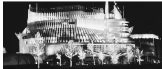
Au pavillon de la France du Casino de Montréal, les 4800 repas servis par jour ont provoqué des colmatages à répétition et des coûts d'entretien élevés.
