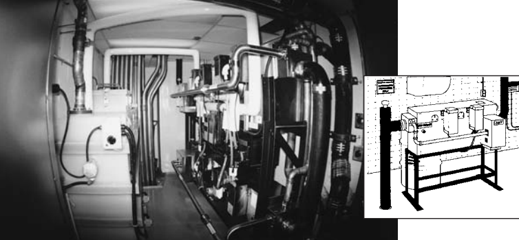
Aperçu des séparateurs de graisse superposés et du bac de récupération (à g.). En mortaise, schéma d'une installation plus simple avec un bac de 45 gal. à l'arrière.
