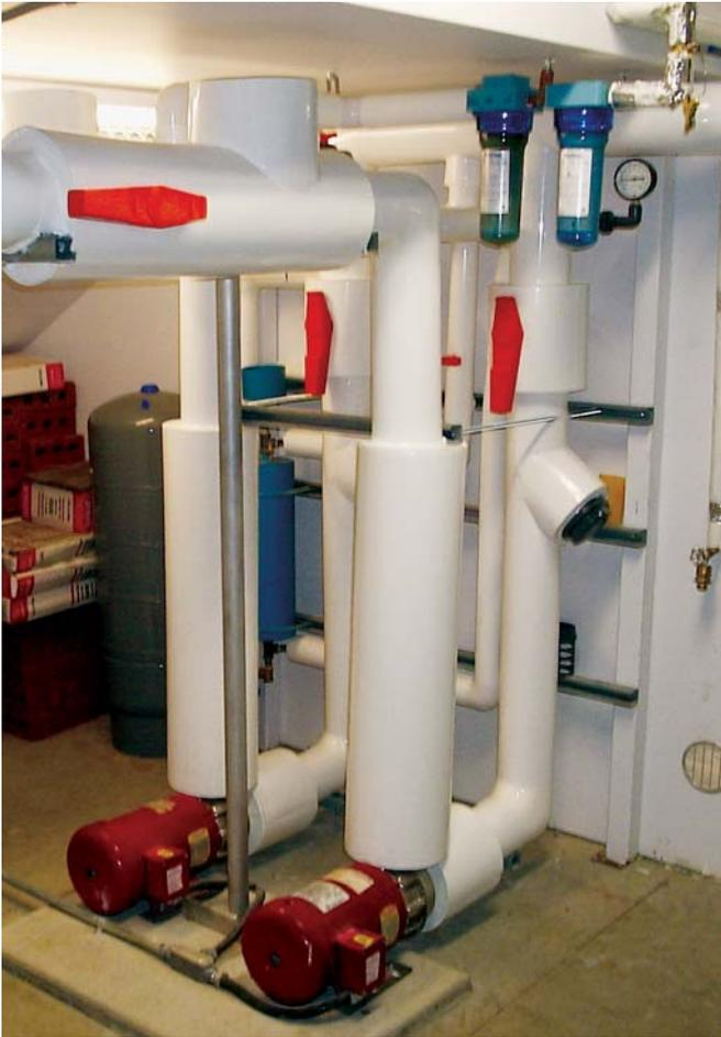
Dans ce projet où le caloporteur ne contient pas d'antigel, les 2 pompes redondantes assurent la circulation du même fluide dans l'échangeur géothermique et dans la boucle de distribution du bâtiment.
