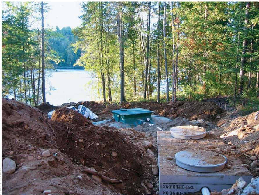
Le Biofiltre Ecoflo est une des alternatives au champ de purification classique. Les eaux usées prétraitées par la fosse septique (à l'avant-plan) se déversent dans un réservoir rempli de tourbe de sphaigne qui agit comme un filtre; les eaux s'écoulent dans le sol sous le caisson.
