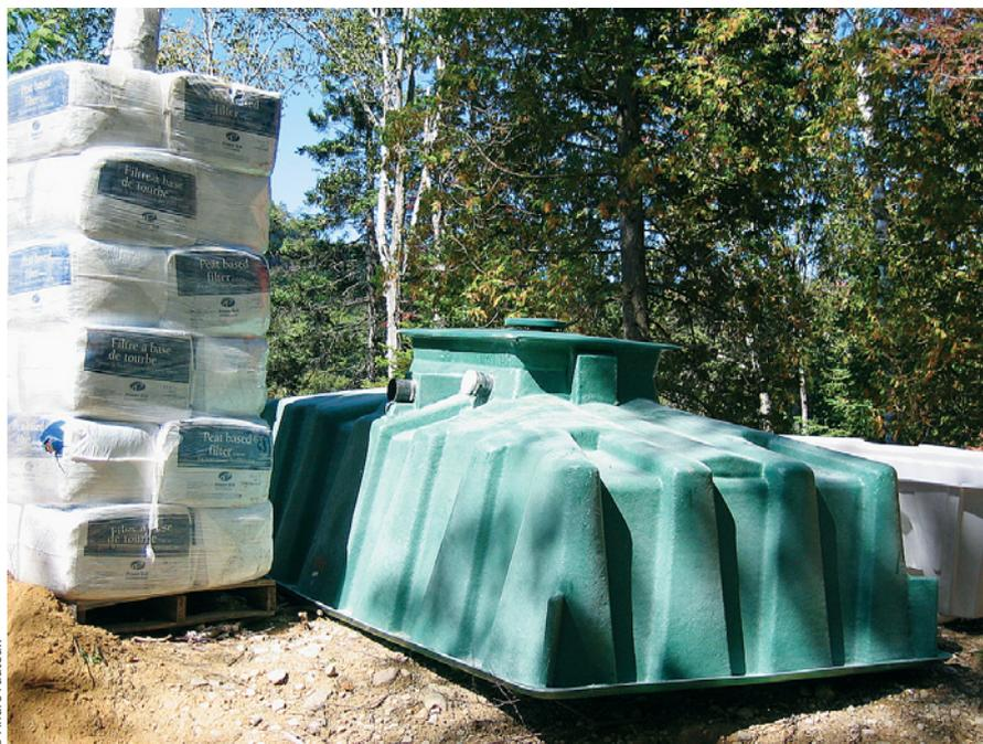
Le réservoir de fibre de verre du Biofiltre Ecoflo est habituellement sans fond. On le remplit d'environ 80 cm de tourbe de sphaigne, un matériau fibreux stable et très poreux qui filtre et retient l'effluent qui y percole.
