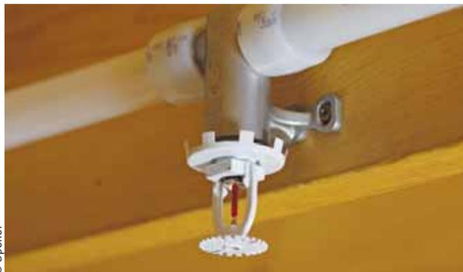
Gicleur Reliable sur une boucle Aquasafe constituée du même tube PEX que pour l'eau potable.
