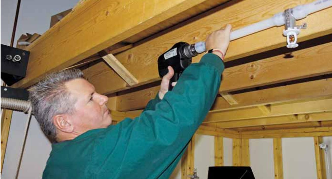
Les raccords ProPEX se font rapidement, sans soudure et sans colle.
