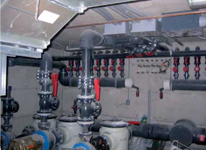
2 vues de la salle de mécanique. On remarque sur le mur du fond la série de piquages effectués sur un collecteur principal, sur le même principe qu'un collecteur de chauffage hydronique, ce qui a permis de réduire considérablement l'espace qu'aurait nécessité l'utilisation de raccords à brides.
