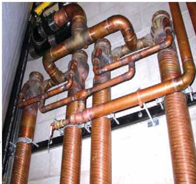
Figure 2 : 4 récupérateurs PowerPipe installés en parallèle
