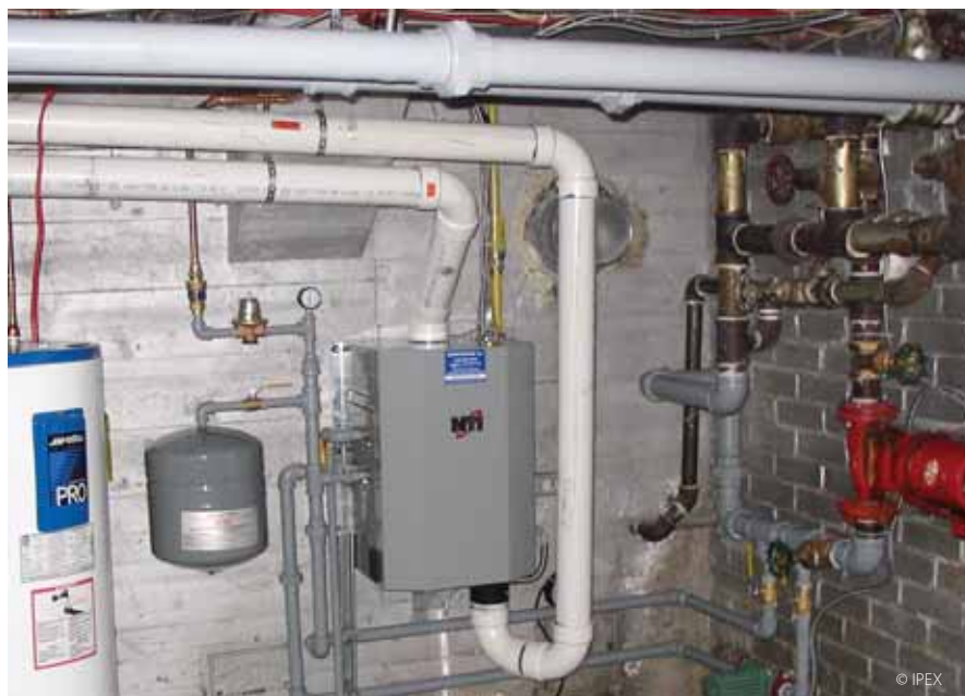
Conduits d'amenée d'air et d'évacuation en PVC pour système basse température.
