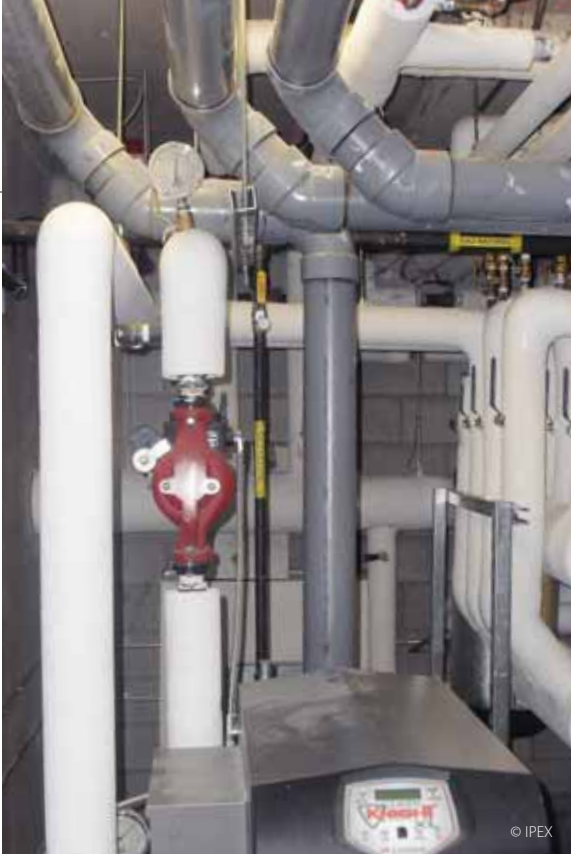
Conduits d'aménée d'air et d'évacuation en CPVC
