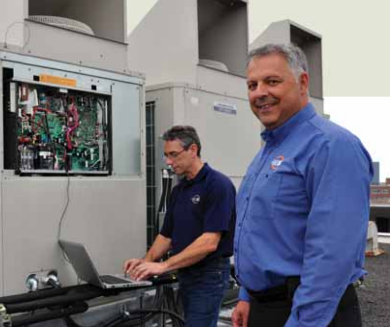
Francis Brodeur, directeur Technologies du bâtiment, et Michel Bergeron, président de Multi-Énergie Best, procèdent aux derniers réglages des 4 unités extérieures Mitsubishi City Multi DRV-R2, à débit variable de frigorigène.
