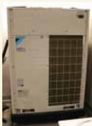
Le système VRV, à l'instar d'un refroidisseur à récupération de chaleur, fait circuler un fluide frigorigène, plutôt que de l'eau. La technologie VRT
