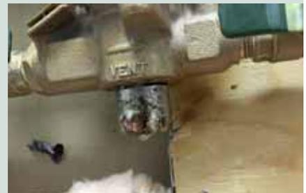
soupape de décharge. Le technicien et son superviseur ont alors recommandé d'enlever le bouchon, d'installer un raccord coupure antiretour et de relier la soupape de décharge à un drain. Peu de temps après la modification, Richard est revenu tester le dispositif.
