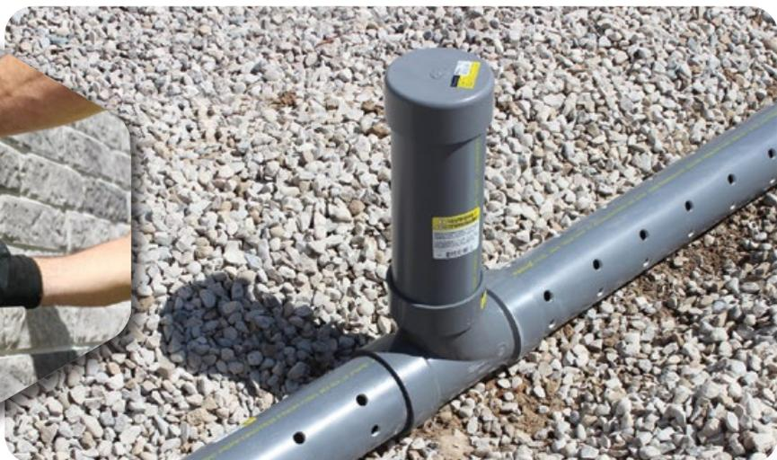
**WOLSELEY CANADA EST FIER D'OFFRIR LA TUYAUTERIE RADON X<sup>MC</sup> EN PVC SPÉCIALEMENT CONÇUE, TESTÉE ET ÉTIQUETÉE**, la première solution capable de répondre au besoin de collecter et d'évacuer les gaz souterrains de la zone de la sous-dalle qui aide à réduire les niveaux de radon à l'intérieur d'un bâtiment.
