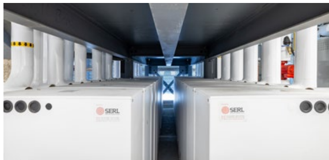
48 unités permettent de réaliser une banque thermique de plus de 720 kWh.
