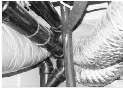
À ne pas faire. La planification soignée des travaux évite un tel enchevêtrement de conduits et de conduites. Les débits d'air en souffrent inévitablement.
