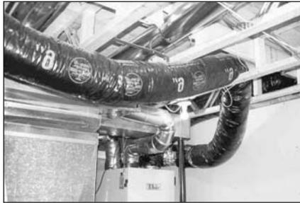
À ne pas faire. Autre exemple fréquent de pincement de conduit d'air. Inacceptable.
