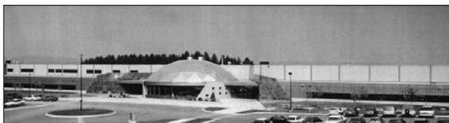
Au *CIMIC*, à *St-Georges*, on a dû forer 44 puits de 100 m de profondeur pour constituer un circuit fermé. Cette installation primée de 120 tonnes est rentable après 4,8 années. À *Montréal*, au 930 *Wellington*, un édifice construit en 1923 et rénové en 1996, on a opté pour un système géothermique avec puits artésien dont l'installation a coûté environ 145 000 \$ de moins qu'un système conventionnel tout en procurant des économies récurrentes annuelles de 6500 \$.
