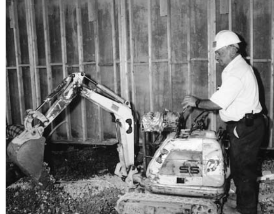
La micro-excavatrice Kobelco accélère la tâche du creusage : une tranchée de 28 pi de longueur et de 24 po de profondeur a pu être creusée dans le gravier en 15 minutes. Sans effort et sans mal de dos.
