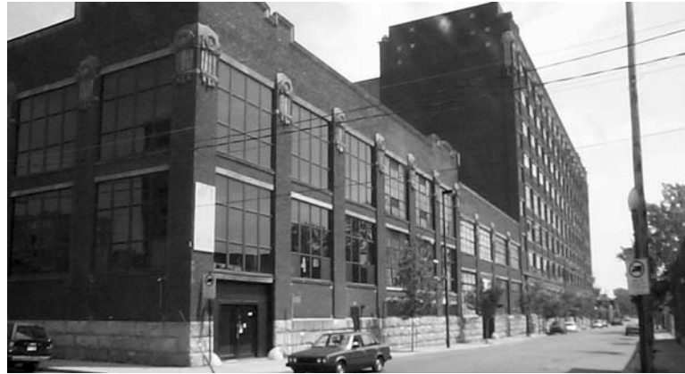
L'édifice le Nordelec est un des plus grands bâtiments en briques au Canada. La superficie totalise 1 million de pieds carrés avec une charge de chauffage de 24 millions de btu/h.
