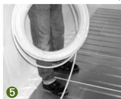
12 panneaux de transitions de 4" x 24". Conçu actuellement pour la tubulure PEX de Roth de 3/8" de diamètre, les panneaux ont une épaisseur de 3/4", une capacité portante de 90 lb/po<sup>2</sup> et un facteur d'isolation de R8, soit le double du polystyrène extrudé haute densité standard utilisé pour couler du béton (45 lb/po<sup>2</sup> et R5.5/po). La tubulure peut être insérée dans les rainures en marchant dessus ⑤; dans les courbes de retour, un jeu laisse place à la dilatation ⑥.
