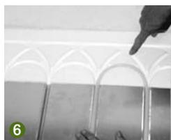
Ce système de panneaux isolants de sous-plancher s'ajoute à la tubulure PEX et au système de contrôle MultiTherm pour faire de Roth un fournisseur de système complet pour le chauffage par plancher radiant.
