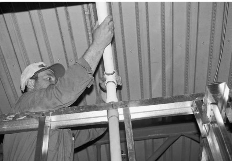
*Un instructeur (qui ne porte malheureusement pas le casque) montre comment le tube de PVC XFR ignifuge prolonge un tube du Système 15 dans un plafond servant de plénum.*
