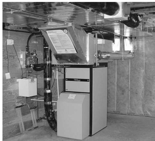
Cette installation de l'AquaMaster inclut l'option de chauffage par plancher radiant pour le sous-sol.
