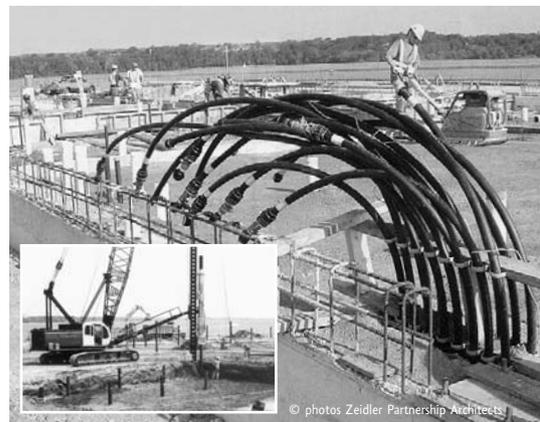
Les 57 pieux de fondation servent de fourreaux aux 104 boucles de mélange glycolé totalisant 40 000 pi de tubulure.
