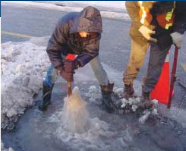
Une dépisteuse de fuite du secteur Sud-Ouest de Montréal en train de fermer une vanne afin qu'on puisse colmater une des nombreuses fuites qui surviennent en hiver.
