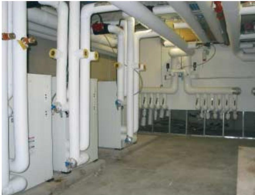
*Thermopompes géothermiques reliées aux puits.*
