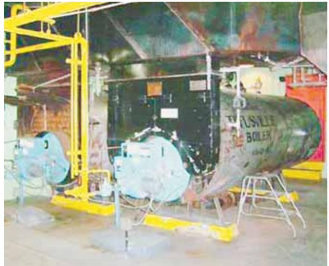
Le « désamiantage » des 2 chaudières de type Volcano a causé la surchauffe des locaux situés au-dessus de la chaufferie.
