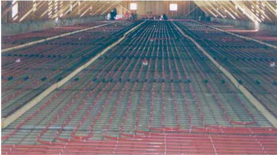
À gauche, une bonne idée de la disposition de la tubulure avant qu'elle soit recouverte de béton. En bas, 2 des 3 chaudières à condensation qui assurent la puissance de chauffe.
