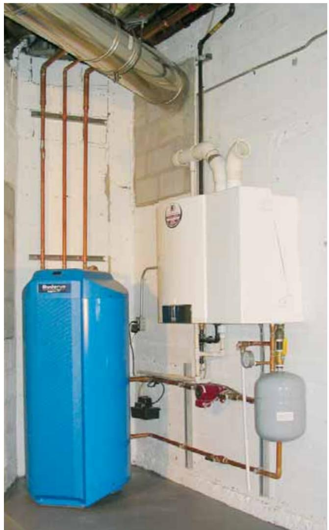
L'eau chaude sanitaire est produite par une chaudière à condensation Buderus de 198 000 btu/h et un chauffe-eau indirect Buderus. Dans cette configuration, même si la chaudière ne condense pas, elle atteint tout de même 89 à 90 % d'efficacité et répond au penchant du propriétaire pour la haute technologie.
