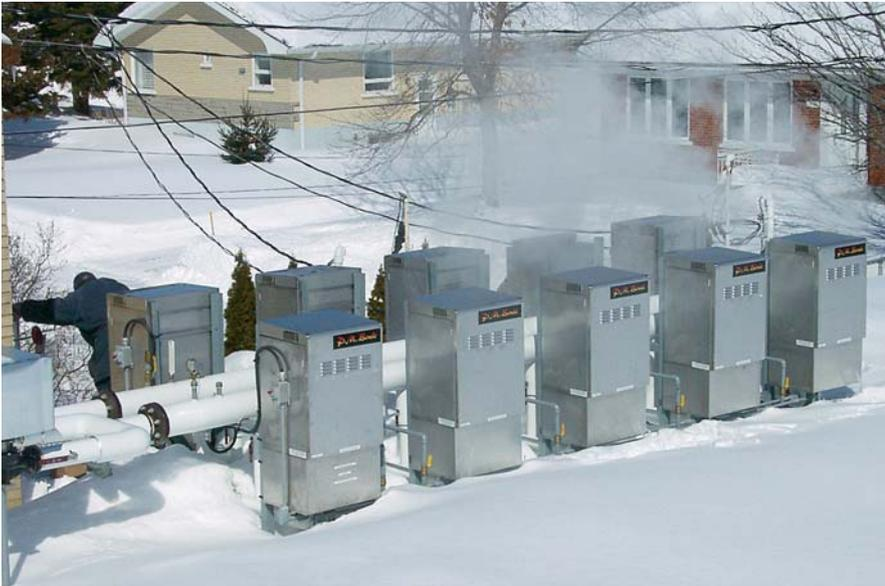
*On a opté pour l'installation de 10 chaudières PM Bowle, pour un total de 2000 MBH, sur le toit de ce centre commercial, plutôt que de démolir des murs pour sortir et remplacer la vieille chaudière originalement installée au sous-sol.*
