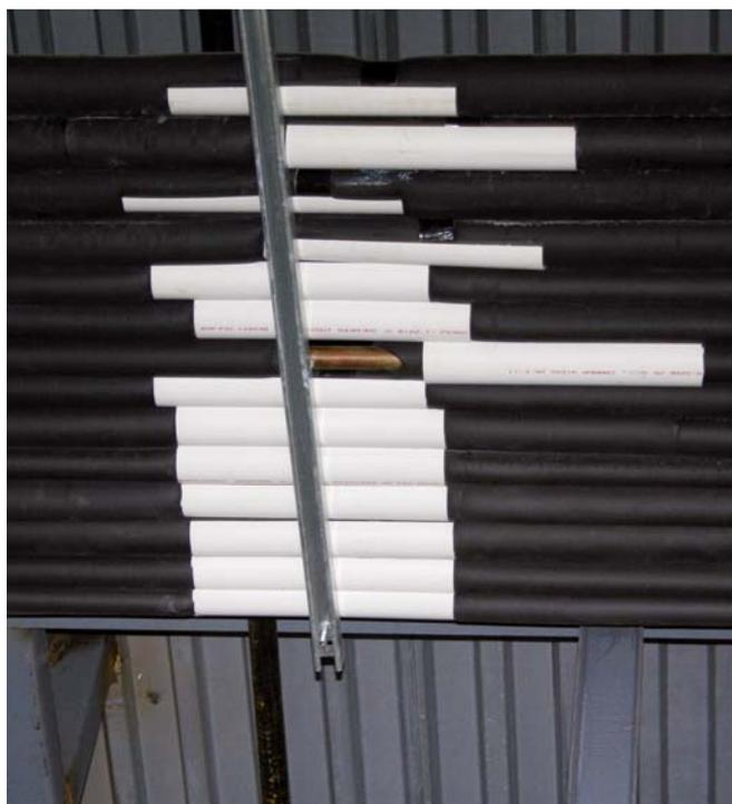
*Ces protecteurs artisanaux n'ont pas résisté aux mouvements répétés de la tuyauterie. L'isolant a été arraché par frottement laissant le cuivre en contact avec la cannelure, ce qui provoquera éventuellement une fuite de réfrigérant.*
