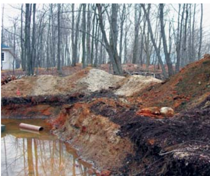
Avant de construire sur un site, il est important d'analyser les conditions du sol. Le phénomène de l'ocre ferreux n'est propre à aucune région en particulier, mais plutôt à un type de sol riche en fer soluble.
