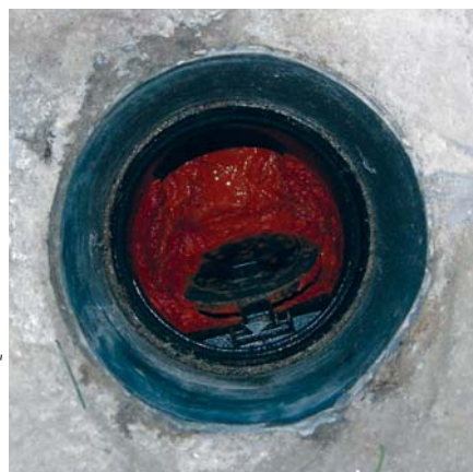
C'est la prolifération de certaines bactéries qui est responsable du colmatage du drain français.
