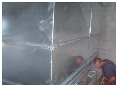
*Le système de raccordement Nexus se prête à toutes les configurations des réseaux de distribution et à différentes pressions de service des systèmes de ventilation. Les sections de conduit sont raccordées au moyen de brides sur mesure pré-assemblées.*
