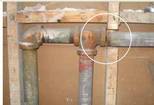
*Cet évier de lavabo, découvert tel quel, a laissé les gaz d'égout s'échapper à l'intérieur de l'espace habité. Comme pour l'alimentation d'eau, les tuyauteries de ventilation en acier galvanisé se révèlent tout aussi fragiles à la corrosion au niveau du filetage, un point faible des tuyauteries métalliques filetées.*
