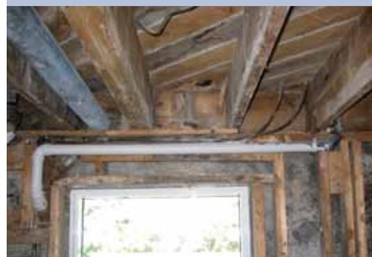
*Le raccordement de l'évier de cuisine à la colonne de chute a été remplacé par une tuyauterie de plastique. Notez l'absence de pente et même une légère contre-pente. Qui a réalisé ces travaux? Pas moyen de le savoir. Remarquez, sur le mur de fondation à droite, les taches noires de moisissures, causées entre autres par l'absence de pare-vapeur lors de la construction en 1960.*
