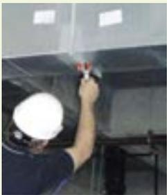
Voici un système d'étanchéisation révolutionnaire exclusif, mis au point par l'équipe de recherche et développement de Hardcast. Il permet à l'entrepreneur de pulvériser
