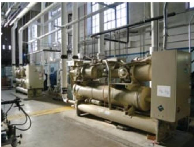
*Deux refroidisseurs McQuay de 190 tonnes combinent la plus grande partie des besoins de chauffage.*
