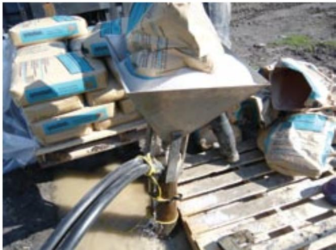
*L'air étant un isolant, les puits géothermiques ont été remplis de sable de quartz et d'eau. L'absence d'aquifère a permis l'utilisation du quartz, qui présente une meilleure conductivité thermique que la bentonite.*
