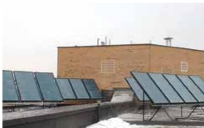
*Du glycol agissant comme liquide caloporteur absorbe la radiation solaire qui frappe le capteur. En traversant un échangeur de chaleur, il transfère l'énergie solaire thermique au réservoir de stockage d'eau chaude solaire. Système installé sur Les habitations Saint-Firmin, boul. Henri-Bourassa Est, à Montréal.*
