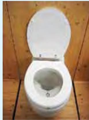
Plusieurs modèles de toilettes séparatrices existent : des sèches, certaines avec transport sous-vide et d'autres à petit volume d'eau, le type plus répandu. Au moins 4 fabricants offrent des toilettes séparatrices à petit
