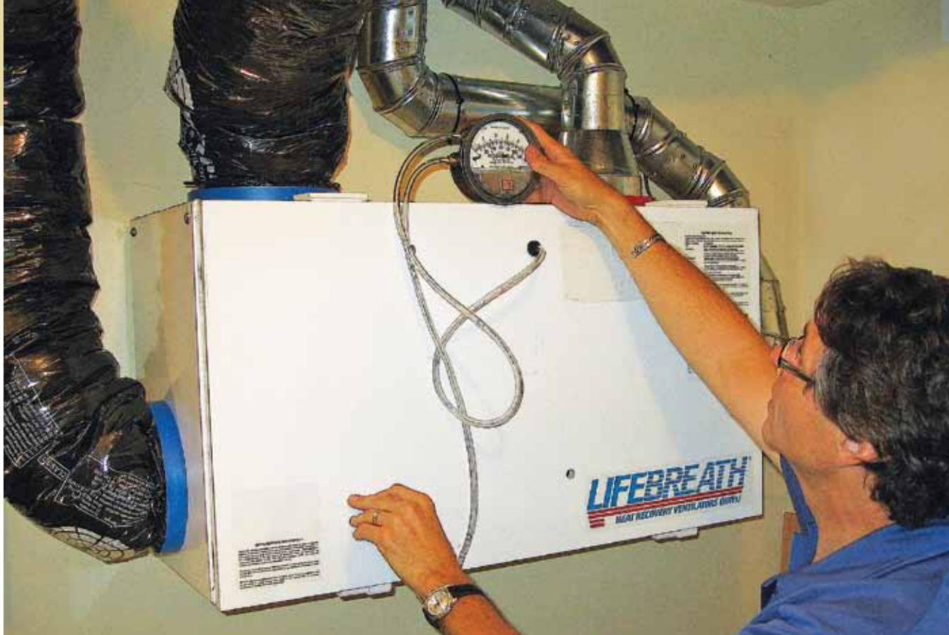
Grâce aux postes de mesure de débit intégrés dans le VRC Lifebreath, François Vanasse effectue l'équilibrage précis des débits d'alimentation et de retour en 5 minutes à peine.
