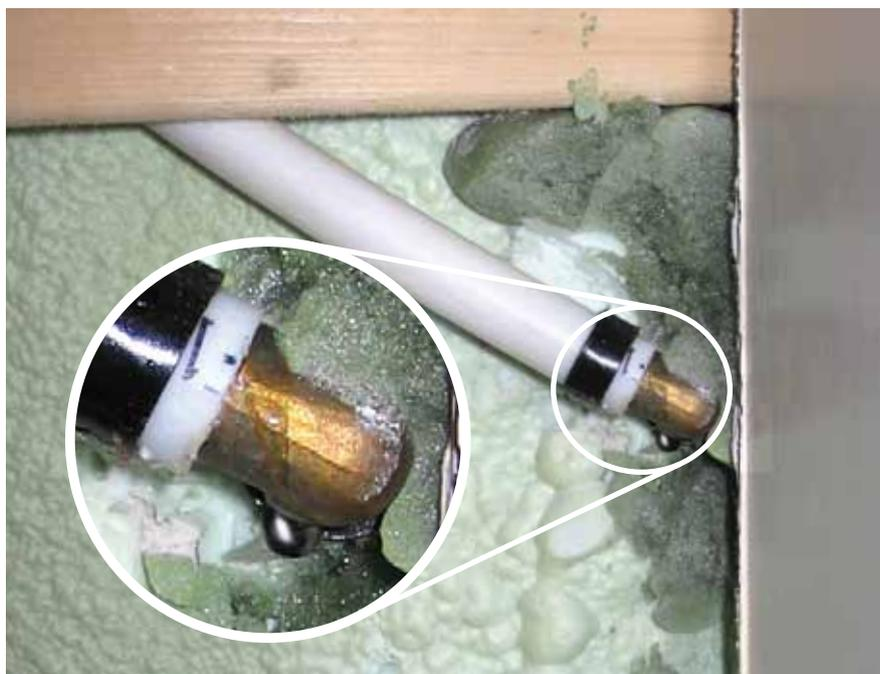
*Ce sertissage, en apparence réussi, laisse fuir une goutte d'eau à toutes les 3 minutes à l'intérieur du mur.*
