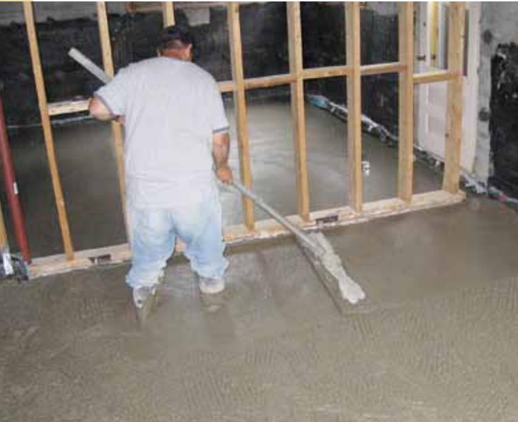
**Bien que l'entrepreneur de chauffage ne soit pas responsable de la finition du béton, une apparence soignée et le respect du niveau ou des pentes requises contribueront à la satisfaction du client lorsqu'il sera temps de passer à l'étape du revêtement. Le surplus de la bande isolante périphérique sera arasé au niveau du béton sec ou, plus tard, au niveau du revêtement.**
