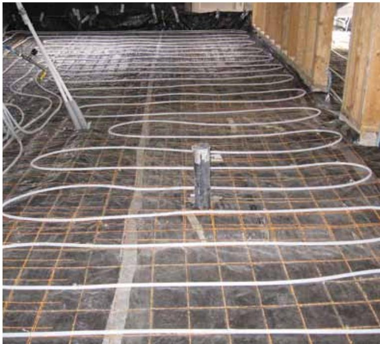
*L'espacement des tubes à 30 cm (12 po) convient à la plupart des applications de dalle chauffante sauf dans la bande extérieure.*
