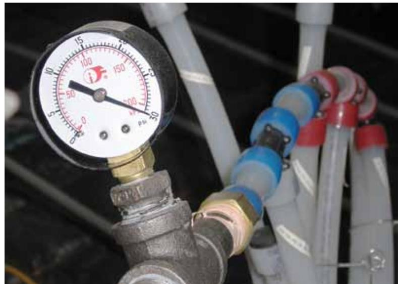
*Pour des raisons particulières, ce test de pression de plus d'une semaine a été fait à 30 psi. Seule la température du béton, plus froide, a fait baisser légèrement le manomètre après la coulée. Ici, l'installateur a préféré réaliser un collecteur improvisé plutôt que de soumettre le collecteur définitif aux réalités parfois dures d'un chantier.*
