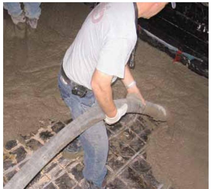
*Le pompage du béton, maintenant courant même dans le résidentiel, soumet le système hydronique à une moins rude épreuve que le transport par brouette. Un isolant anti-rayonnement de qualité, un treillis métallique et une tuyauterie PEX solidement attachée forment un ensemble qui résiste bien au piétinement et à la coulée de béton.*
