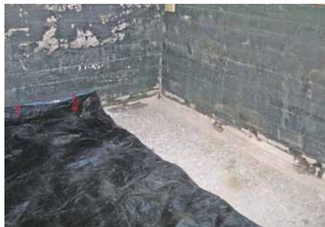
*Dans cette rénovation où la tuyauterie souterraine était à refaire en entier, on en a profité pour remplacer la dalle originale par un plancher chauffant. Sur le sol, à gauche on voit la membrane anti-rayonnement multicouche (en noir). On voit comment cet isolant servira en même temps à désolidariser la dalle chauffante de la semelle et des murs de fondation.*
