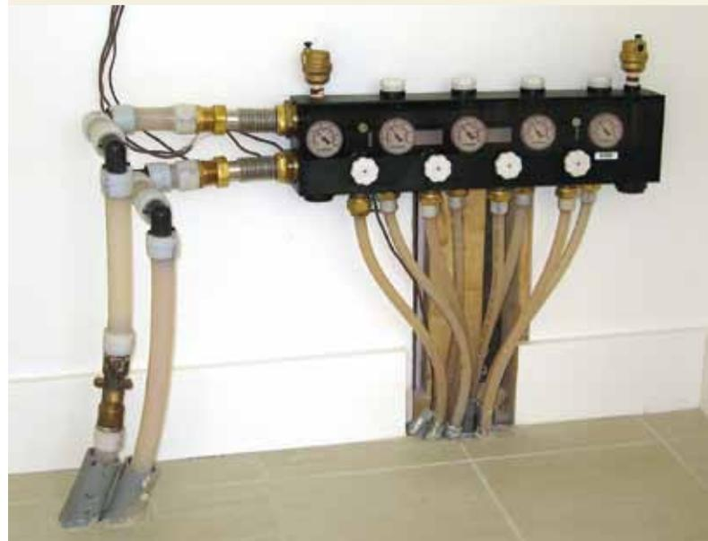
**Installé en apparent dans un placard, ce collecteur alimente 4 boucles. Un décalage entre le plan des conduites principales d'alimentation et de retour et celui des boucles a obligé l'installateur à poser 2 coudes supplémentaires pour rejoindre l'axe du collecteur.**
