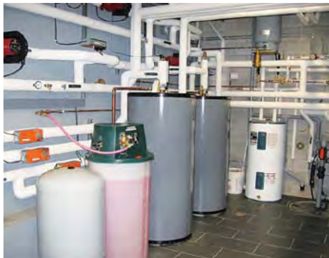
La variation du niveau du réservoir, avec ou sans alarme, permet d'obtenir un indice précoce d'une fuite éventuelle dans le système.
