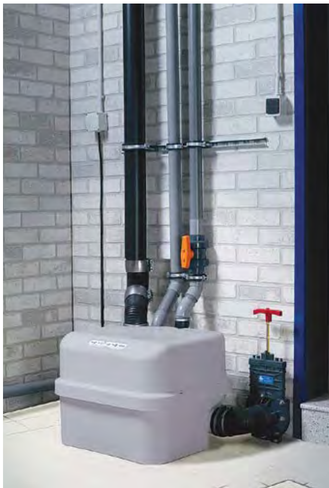
On peut alimenter la mini-station de relevage par 5 orifices d'entrée; l'évacuation des eaux usées se fait par un tuyau de 1½ po raccordé sur le dessus.
