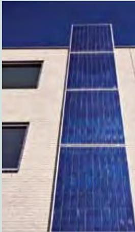
Comme peu de maisons ont une toiture à forte pente au Québec et que les supports augmentent les coûts d'installation tout en exposant le dos des capteurs au vent, les chercheurs du LTE ont été amenés à considérer que le toit n'est peut-être pas le meilleur endroit pour tirer profit de l'énergie solaire. Les inconvénients constatés les ont conduits à réfléchir à une solution de rechange : pourquoi ne pas installer les capteurs à la verticale sur un mur extérieur, à la hauteur du rez-de-chaussée ?
