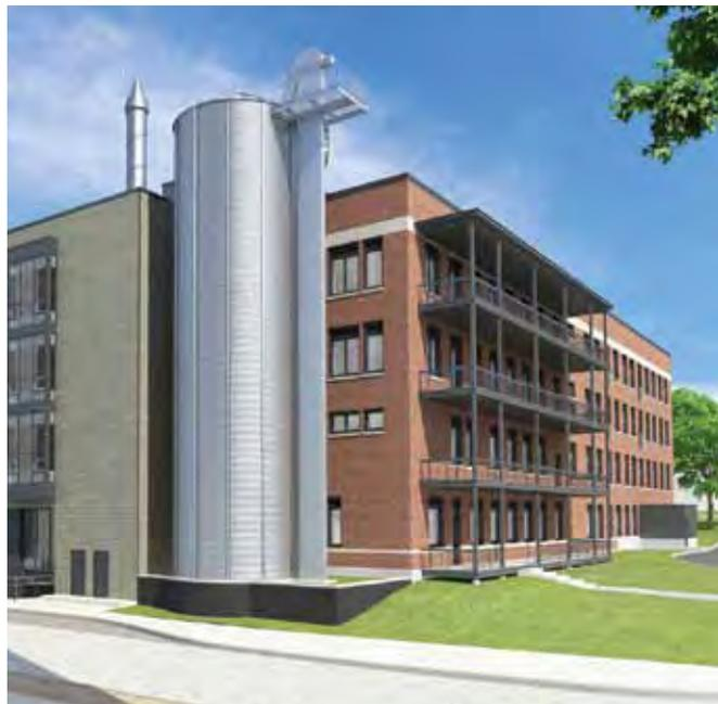
L'énergie primaire de la Cité Verte, à Québec, proviendra de la combustion de 2600 t de granules de bois par année, soit le contenu de 80 camions semi-remorques, qui transiteront par un silo de 6 m de diamètre par 21 m de hauteur.
