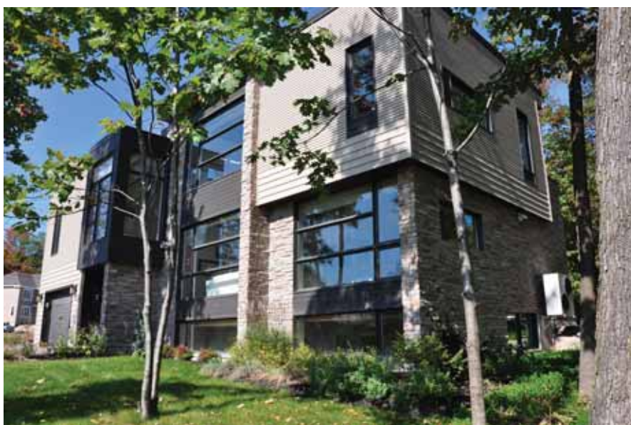
Cette seule maison a valu à Géprotech 2 prix du 28 e concours Domus de l'APCHQ du Montréal métropolitain : - Construction et/ou rénovation résidentielle à caractère écologique et - Construction unifamiliale de plus de 350 000 $ et de moins de 750 000 $.
