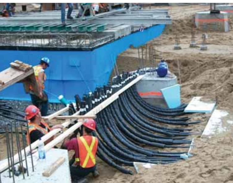
Le système géothermique est constitué de 28 puits de 500 pieds de profondeur. Comme il sera impossible de retourner sous le bâtiment, il n'y a pas de collecteur extérieur et les 56 tubes aboutissent directement dans le local technique.
