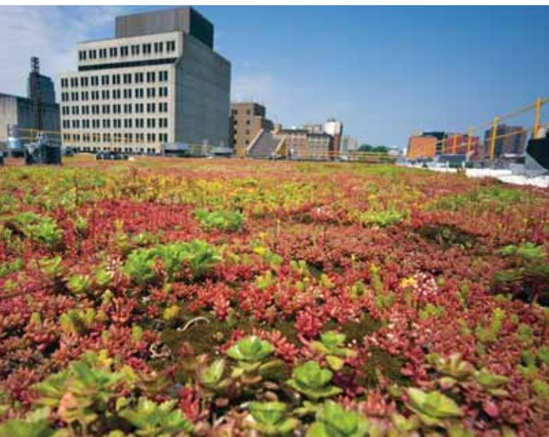
Un toit vert d'environ 800 m<sup>2</sup> contribue à réduire la charge de climatisation et le phénomène d'îlot de chaleur dans le quartier. La végétation contribue à l'isolation des bâtiments et prolonge la vie des membranes de toiture (diminution de l'impact des rayons UV et du stress lié au cycle extension-contraction).
