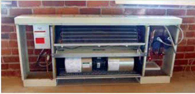
150 ventilo-convecteurs hydroniques distribuent le chauffage et le rafraîchissement à partir d'un réseau de 13 puits géothermiques. Les 150 unités font partie d'un réseau maillé commandé par la technologie Zigbee sans fil.
