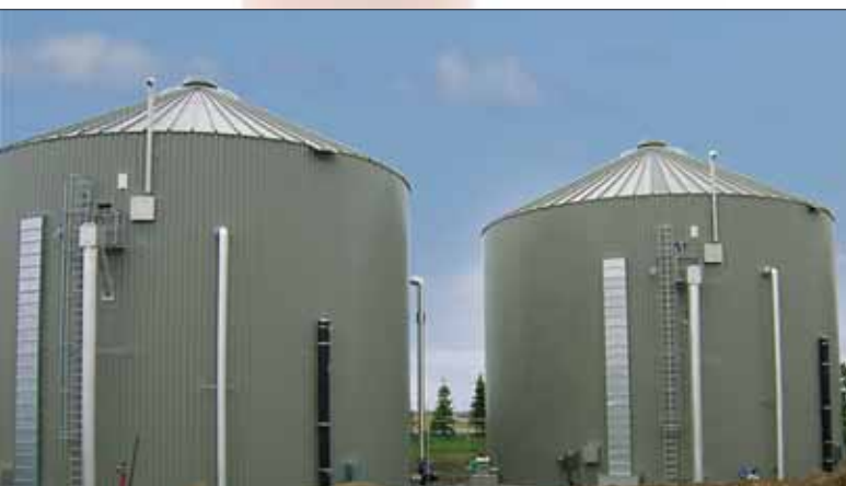
Digesteurs anaérobiques. Chaque tonne de \text{CH}_4 récupérée équivaut à ne pas rejeter 21 tonnes de \text{CO}_2 dans l'atmosphère.
