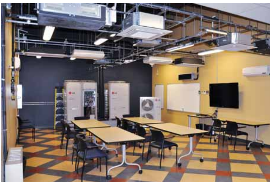
Le laboratoire LG permet de raccorder et d'étudier tous les types de modules internes de thermopompes.
