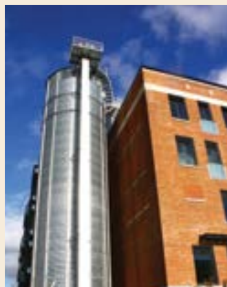
Silo à granules à côté du bloc Nord-Ouest
