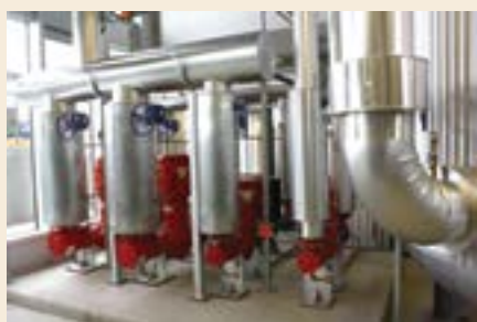
Pompes à eau chaude du réseau urbain. Particulièrement petites grâce à l'optimisation du \Delta T .
