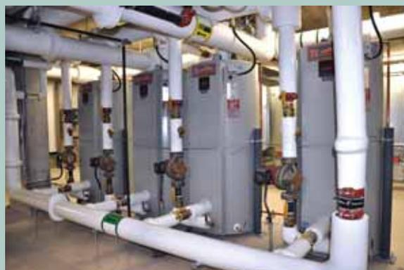
4 chauffe-eau Thermo 2000 Turbomax, alimentés par 2 chaudières Camus Dynaflame à haute efficacité, suffisent à assurer le chauffage de l'eau chaude sanitaire.
