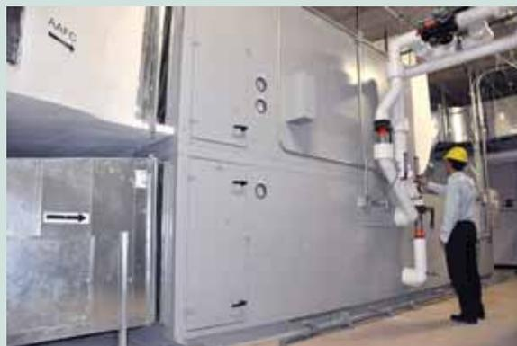
Un technicien vérifie la pression dans la centrale de traitement d'air qui alimente tout le bâtiment en air neuf.
