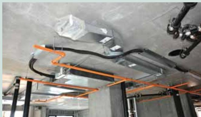
Aperçu des réseaux terminaux de ventilation et de chauffage/climatisation. Toutes les extrémités sont scellées jusqu'à la fin des travaux pour éviter toute infiltration de poussière ou de matières indésirables.
