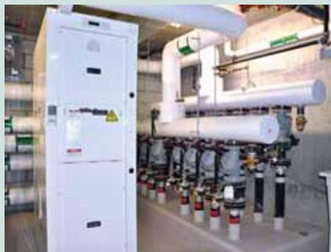
L'une des 3 thermopompes géothermiques près des collecteurs d'alimentation et de retour des 32 puits.
