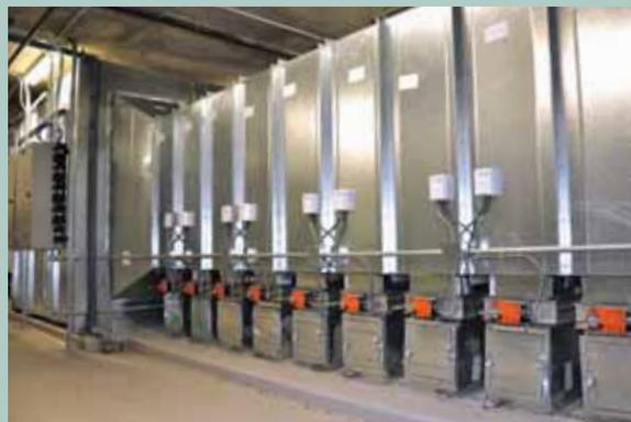
Toute la chaleur évacuée des sècheuses et des corridors est captée par ces conduits de ventilation et récupérée à l'aide d'un échangeur de chaleur pour préchauffer l'air frais.
