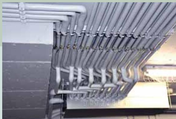
Cette boîte de répartition desservant 8 logements permet de récupérer l'énergie et de la répartir pour des besoins simultanés de chauffage et de climatisation.
