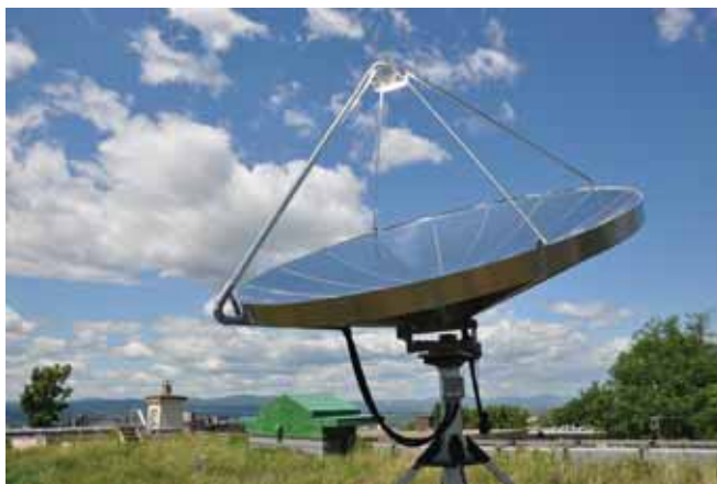
Le concentrateur s'installe généralement au sol mais, au Centre Frédéric-Back de Québec, on l'a installé sur un toit végétalisé sur lequel ne se projette aucun ombrage permanent.
