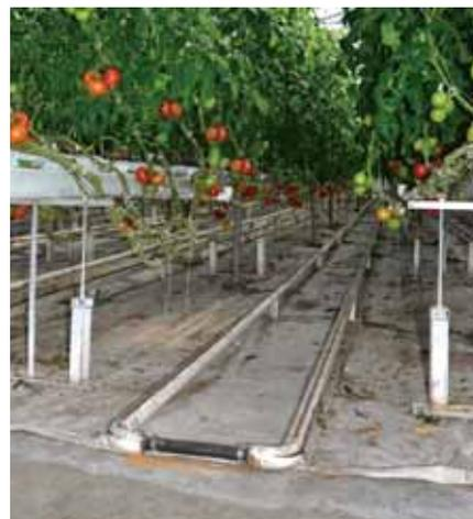
Le chauffage hydronique se fait au moyen de tuyaux d'acier qui servent de rails sur lesquels circulent les chariots du personnel. À une extrémité, un tronçon de caoutchouc relie 2 tubes d'acier pour réaliser une boucle dont l'autre extrémité est reliée aux collecteurs d'alimentation et de retour.
