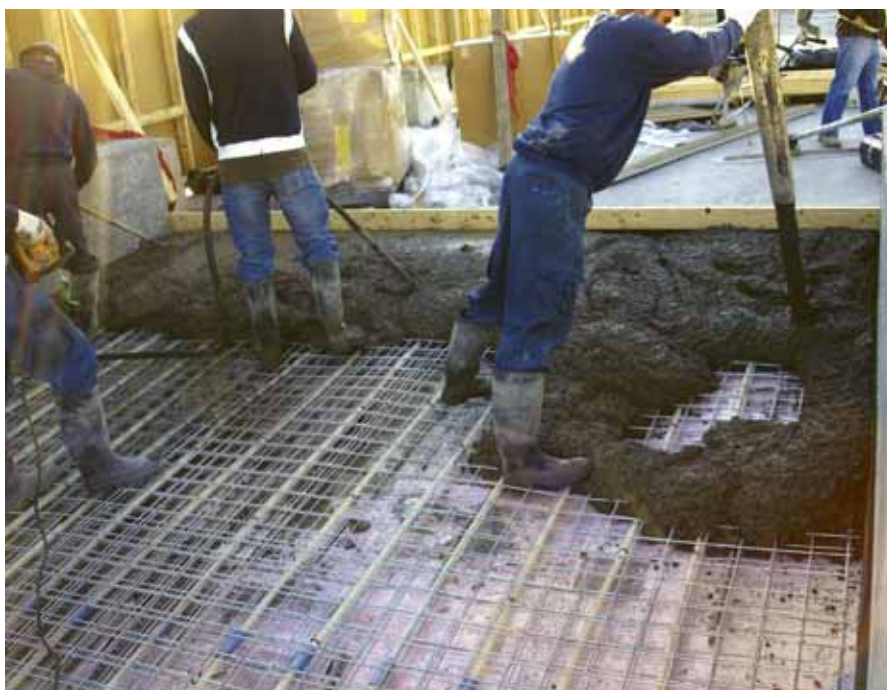
L'entrepreneur devrait assister à la coulée pour coordonner l'information entre les corps de métiers et protéger les installations.
