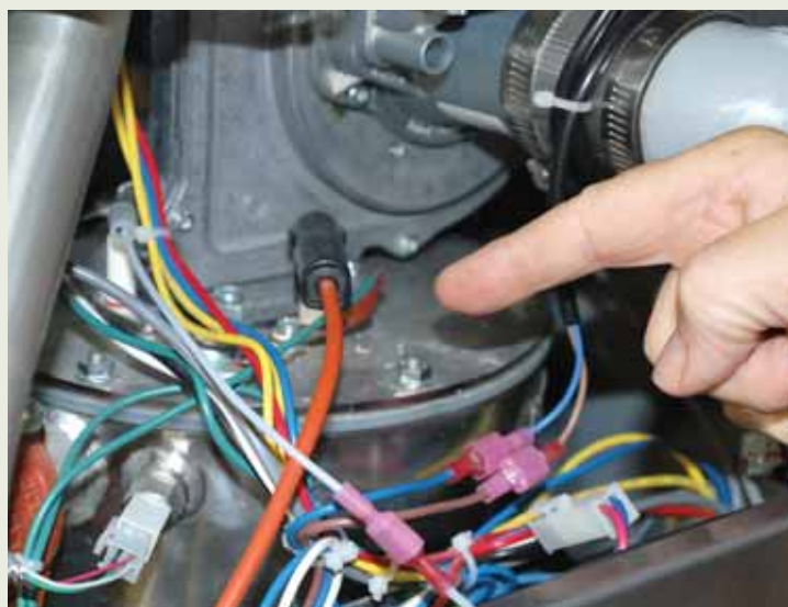
Brûleur à gaz d'une chaudière à condensation
