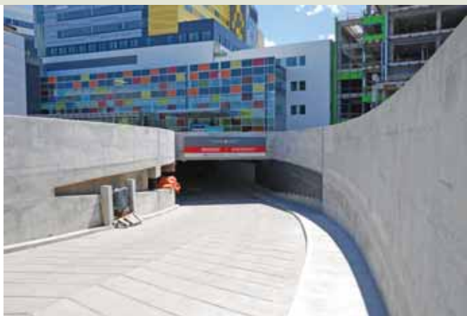
Mesurant 700 m 2 (7 500 pi 2 ), la rampe d'ambulance est l'une des plus longues rampes dotées d'un système de fonte de neige au Québec.
