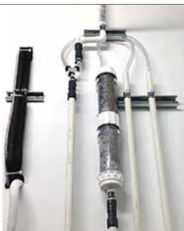
Neutralisateur des condensats
