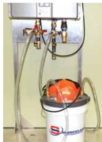
Système de détartrage
