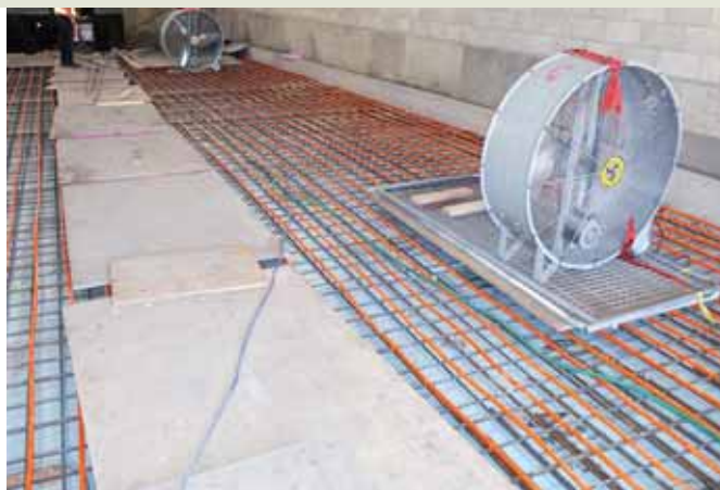
Mesurant 700 m 2 (7 500 pi 2 ), la rampe d'ambulance est l'une des plus longues rampes dotées d'un système de fonte de neige au Québec.
