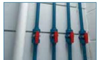
Systèmes non-métalliques pour eau potable pour les constructions commerciales et de grande hauteur
