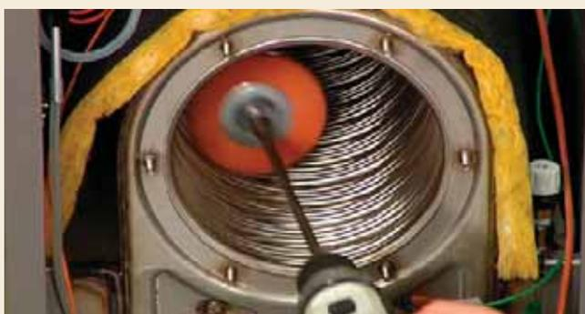
Nettoyage de l'intérieur d'un échangeur de type serpentin.
