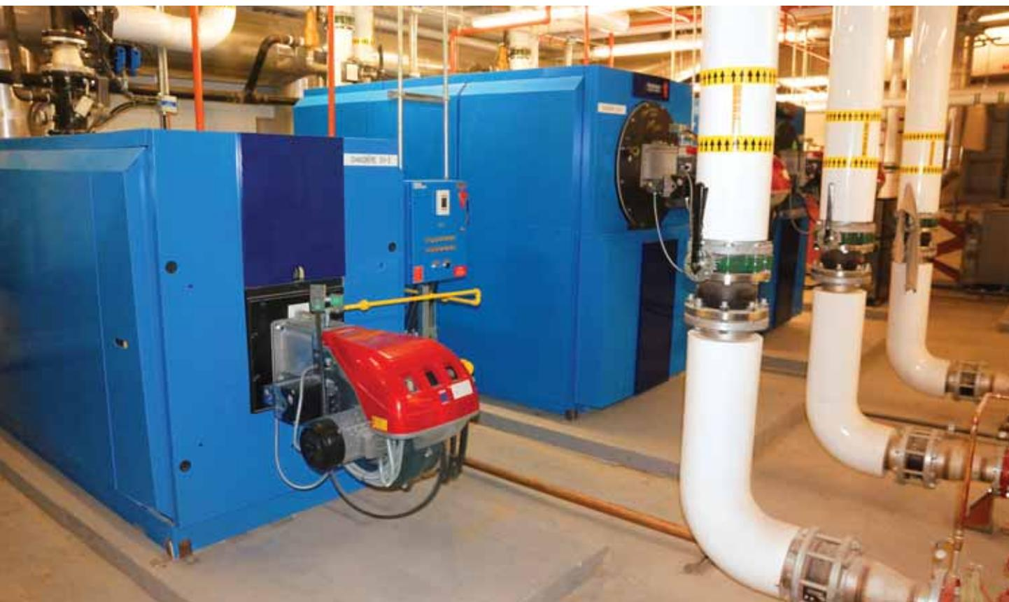
Si la chaudière n'est pas efficace, les produits de la combustion qui sortent de la cheminée seront encore très chauds et la chaudière aura échoué dans sa mission première qui consiste à soutirer le maximum de chaleur des produits de la combustion. À l'inverse, pour que la combustion soit efficace, les produits de la combustion doivent sortir plus froids à la cheminée.
