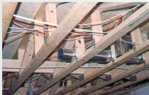
Les poutrelles de plancher à membrures d'une hauteur un peu surdimensionnée représentent habituellement une solution à l'encombrement des conduits.
