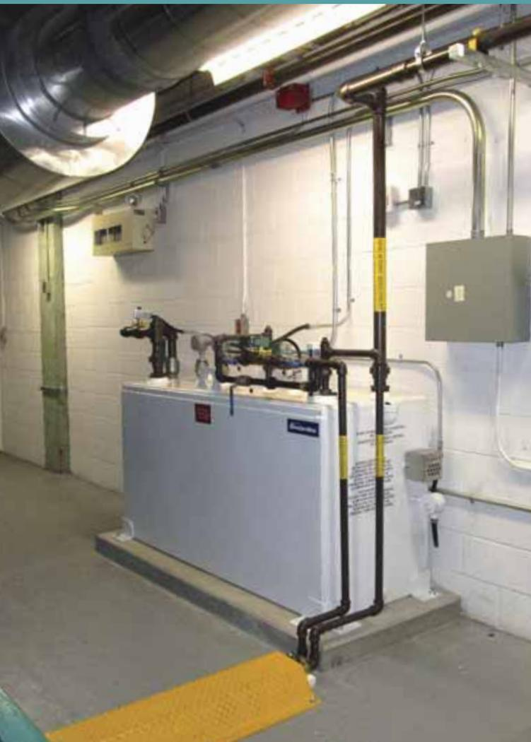
Plusieurs questions se posent lors de l'installation d'un réservoir hors-sol de diesel. A-t-on prévu l'installer au bon endroit ? Est-il correctement installé ? Il m'arrive souvent de constater que l'installation ne respecte pas les normes de dégagement par rapport au mur et, bien souvent, le concepteur n'a pas tenu compte des divers éléments de la pièce.
